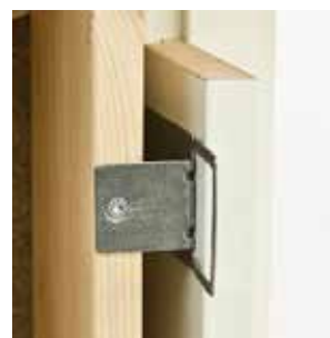
Monteringsbeslag for vindu med utforing.
